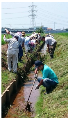
( 水路の掘りざらい )
